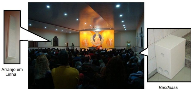
Figura 35 - Sistema de som instalado.
